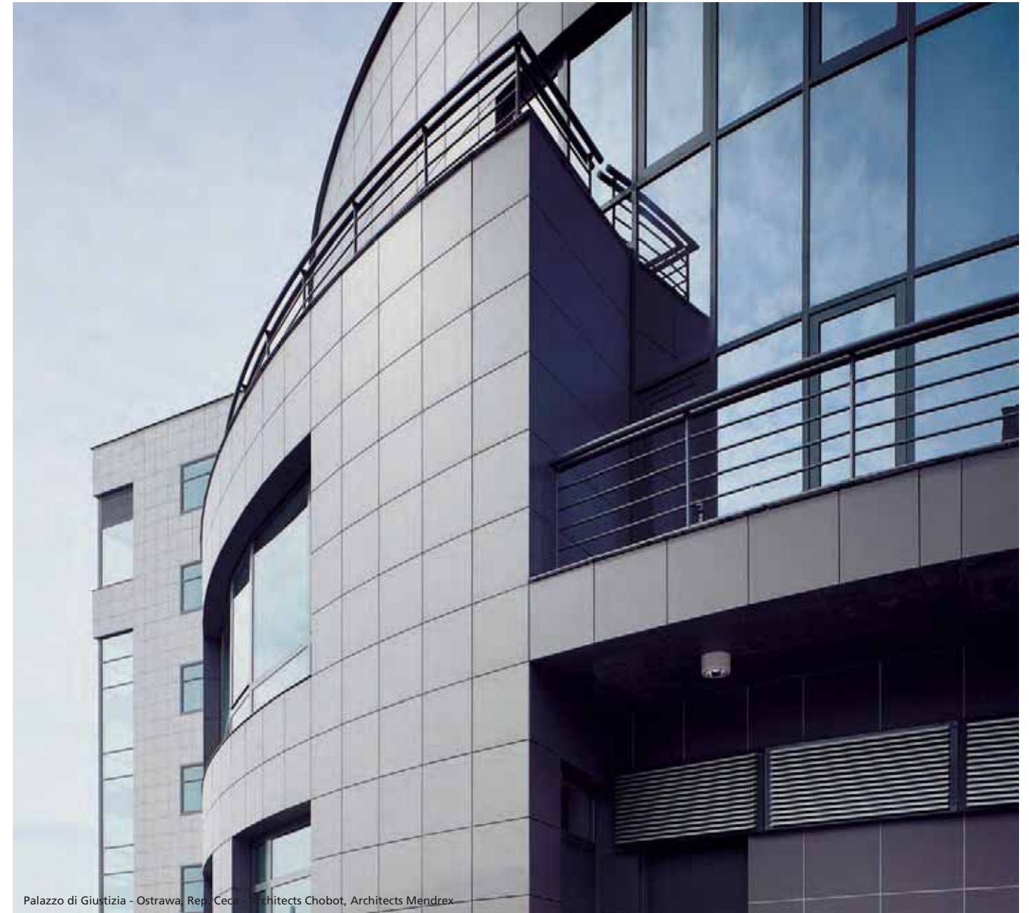
Palazzo di Giustizia - Ostrava, Rep. Ceca - Architects Chobot, Architects Mendrex
